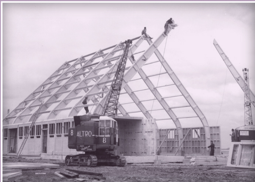
Bouw van een schokbetonnen schuur in de Noordoostpolder, 1949.
