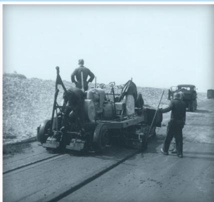
Bouw van de Houtribdijk, 1964 (fotograaf Edzo Ebbens). Links: gestorte keileem langs de 'polderzijde' van de dijk. Rechts: aanbrengen van grindasfaltbeton met een speciale machine.
