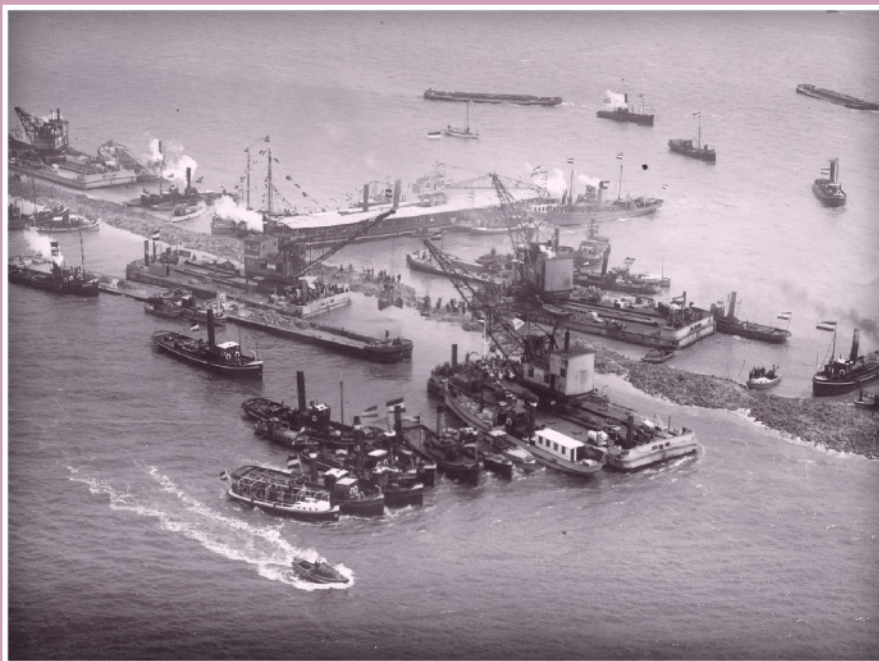
Drukte rond het laatste sluitgat van de Afsluitdijk, 28 mei 1932.
