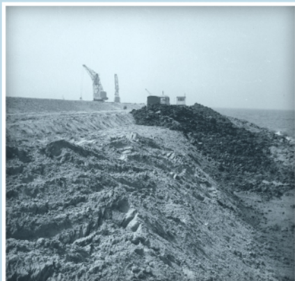
Bouw van de Houtribdijk, 1964 (fotograaf Edzo Ebbens). Links: gestorte keileem langs de 'polderzijde' van de dijk. Rechts: aanbrengen van grindasfaltbeton met een speciale machine.
