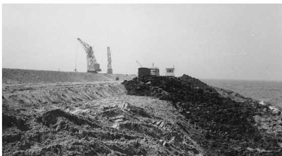
Bouw van de Houtribdijk, 1964 (fotograaf Edzo Ebbens). Links: gestorte keileem langs de 'polderzijde' van dijk. Rechts: aanbrengen van grindasfaltbeton met een speciale machine.
