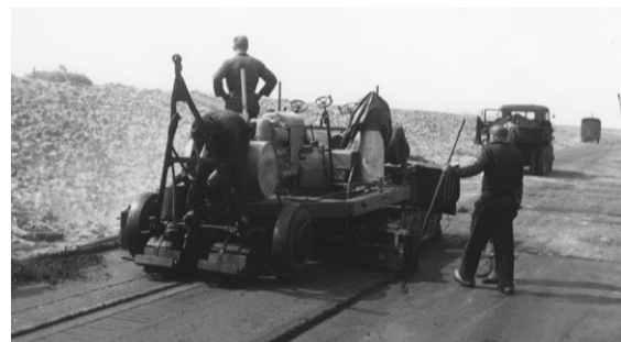
Bouw van de Houtribdijk, 1964 (fotograaf Edzo Ebbens). Links: gestorte keileem langs de 'polderzijde' van dijk. Rechts: aanbrengen van grindasfaltbeton met een speciale machine.
