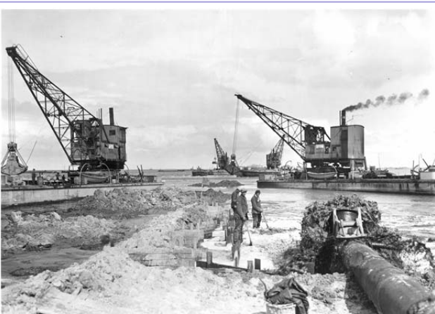
Met kranen wordt de keileem gestort en daarna (op de voorgrond) zand opgespoten, 9 september 1931 (foto K. Maaskant). Fotocollectie Nieuw Land.
