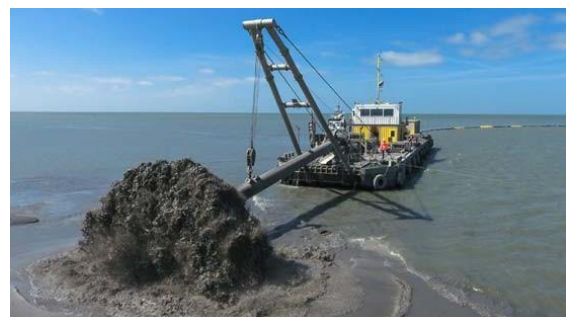
Door zandopspuiting komt het eerste eiland boven water, juni 2016.
